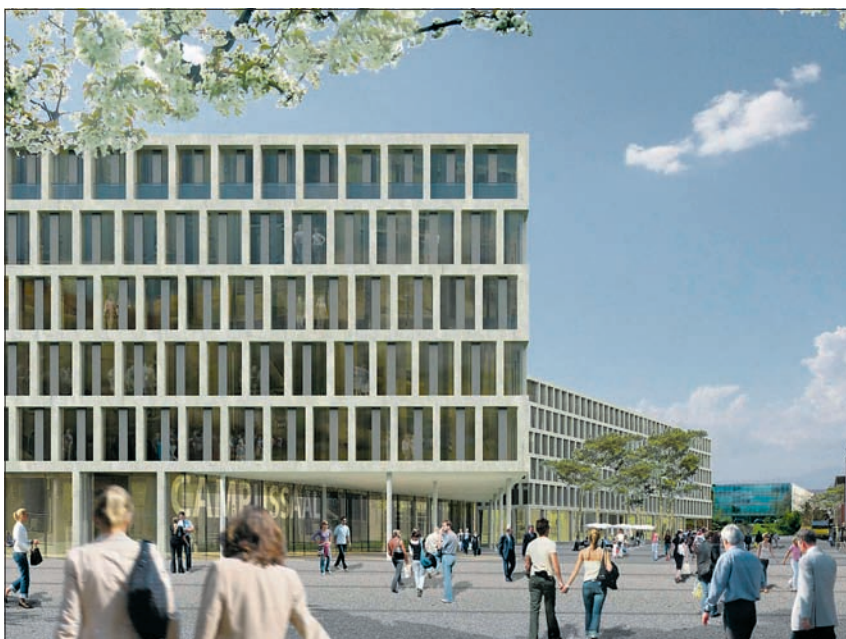
Der neue Campussaal – das Herzstück des Campus
